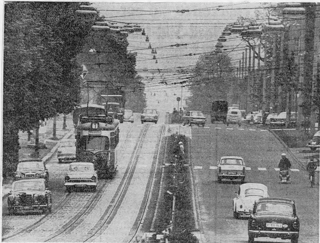
Stadteinwärts ist die Wilhelmshöher Allee bereits von der Staatsbauschule bis kurz vor dem Brüder-Grimm-Platz auf ihre neue Breite mit Mittelstreifen ausgebaut (im Bild rechts). An der Verlängerung über den Brüder-Grimm-Platz hinaus bis in die Friedrichsstraße oder zur Rathauskreuzung wird zur Zeit gebaut. Schon bald soll nun mit dem Ausbau des noch alten Teilstücks mit Basaltpflaster vom Rathenau- platz bis zur Ulmenstraße (im Foto links) begonnen werden. Unser Foto zeigt deutlich, wie die Straßenbahn den fließenden Verkehr blockiert. Das ist demnächst nicht mehr der Fall, da sie nach dem vollständigen Ausbau ihren eigenen Gleiskörper hat. Unser Foto wurde mit einem Teleobjektiv vom Standpunkt an der Staatsbauschule in Richtung Innenstadt aufgenommen. (Aufn.: L)
